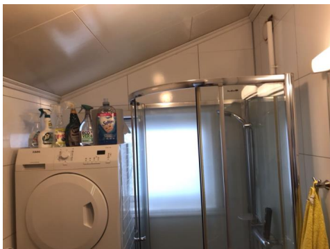
Bildet viser vindu i våtsonen.
